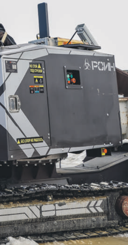
● Российский демонтажный робот на радиохимическом заводе «Маяка»
